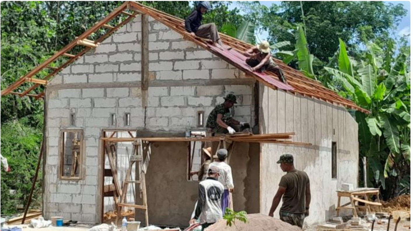
Hari Ke 15, Sasaran Rehab Rumah Sudah Terlihat Hasilnya
